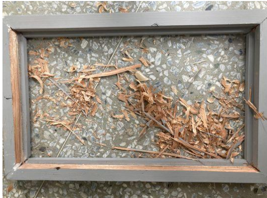
▲ 圖21 外框內側修補
